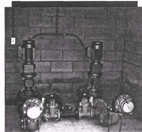
Одновальная дробилка Моупо Pipeliner измельчает твердые вещества в консистентный раствор с частицами приемлемого размера для предотвращения засорения, повреждения или выхода из строя оборудования, расположенного далее по потоку.
